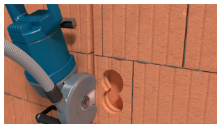
Schlitz mit Fräse neben Bohrungen fräsen, zusätzlich bis kurz vor oder in die Dosenbohrung fräsen.
