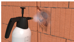
Dosenbohrung leicht anfeuchten, damit Schaum schneller aufquillt.
