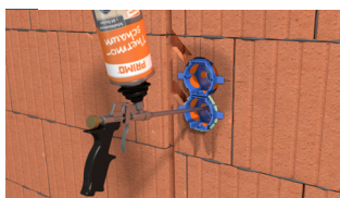
Schaum einsprühen: Wärmebrückenfreie/luftdichte Installation.
