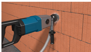
Erste Dose anzeichnen und mit 82mm Bohrkronen ausbohren.
