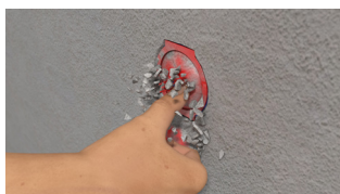
Putzdeckel mit Hand eindrücken oder mit Bohrkronen ausbohren.
