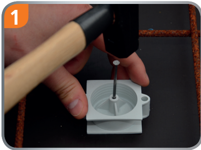
1 Unterteil auf Schalung nageln.
